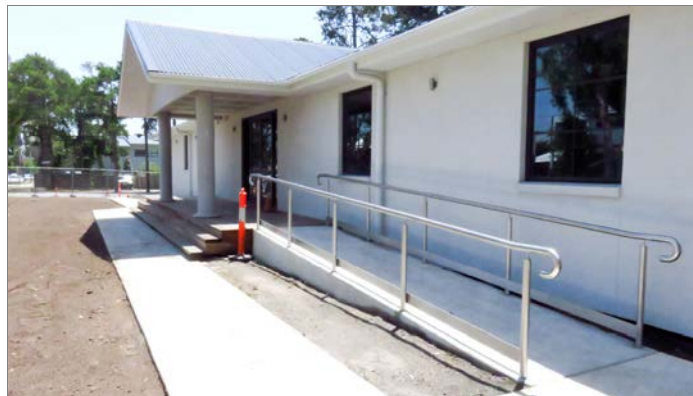
Nad tarasem z tyłu, zbudowano zadaszenie, a z przodu budynku, po obo stronach podjazdu dla inwalidów, zainstalowano barierki.
