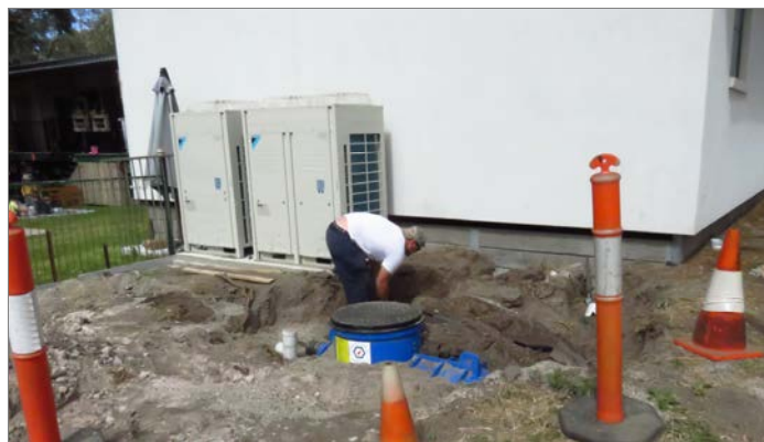
Komercyjna kuchnia została dobrze wyposażona, a na zewnątrz budynku zainstalowano tzw. grease trap – „łapacz tłuszczu”, czyli specjalny syfon kanalizacyjny do odprowadzania tłuszczu.
