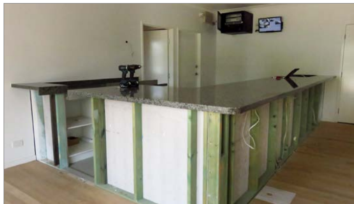
Drewniana podłoga na głównej sali klubowej została położona, a w barze zainstalowano piękny, granitowy, długi blat.
